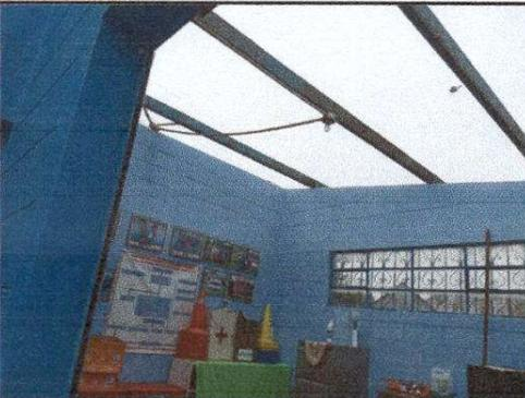
Foto 3: Vigas en mal estado
